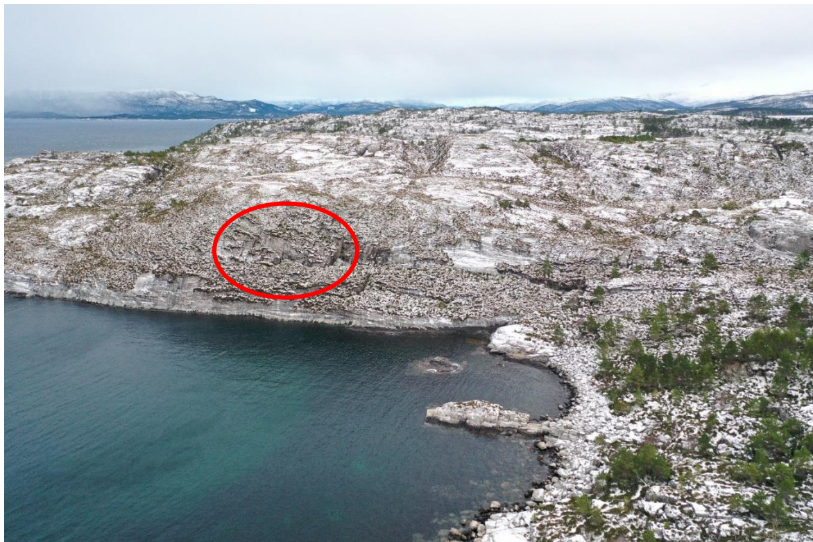
Figur 25: Dronebilde tatt mot øst som viser planlagt forankringspunkt for alternativ 2 på sørsiden av broen.
